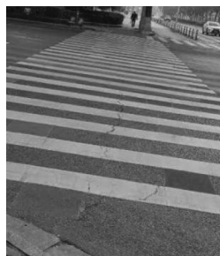
图2 斑马线开裂图
