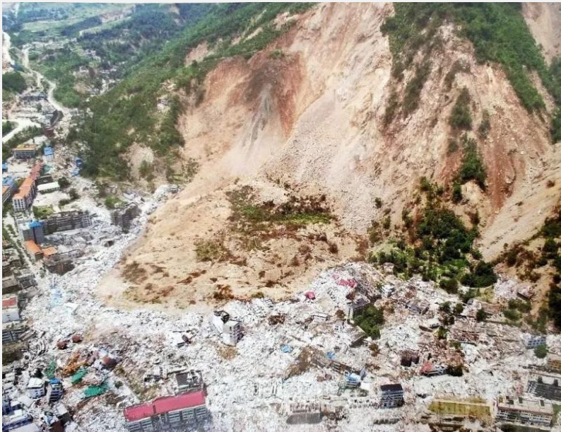
北川县王家岩 滑坡 在几分钟内便掩埋了1/3的北川县城，千余同胞刚刚从建筑物中逃出便被永远掩埋在15m厚的土方下。
